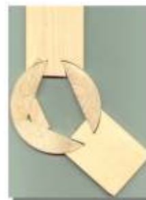
Eckverbindung Erker-Blockhaus
